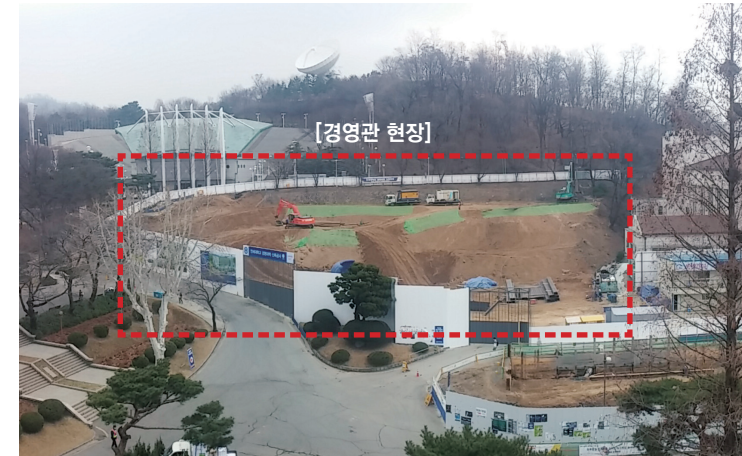
한창 공사 진행 중인 경영관 신축 현장
